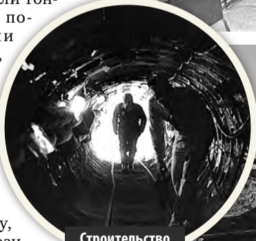
Строительство тоннеля под 4 энергоблоком
