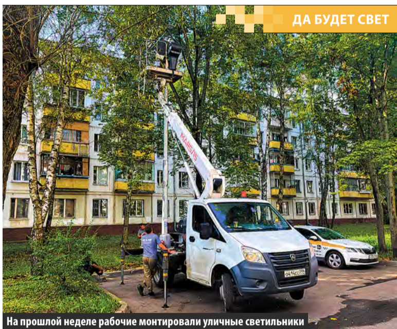
На прошлой неделе рабочие монтировали уличные светильники
