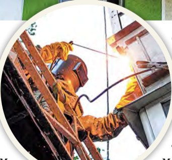
Ремонт домов идет полным ходом
