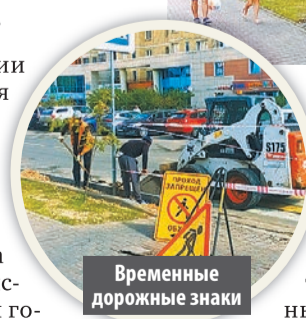
Работы на бульваре закончатся в конце июля
