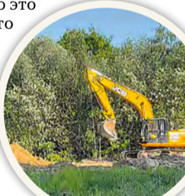
Техника выравнивает место будущей стройплощадки
