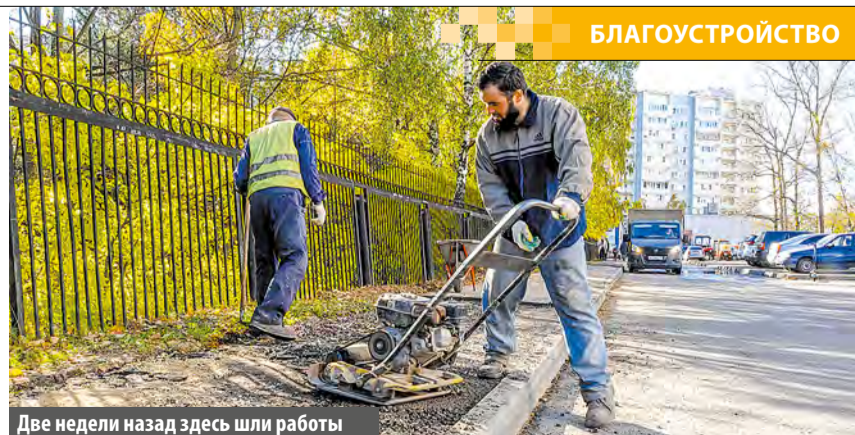
Две недели назад здесь шли работы
