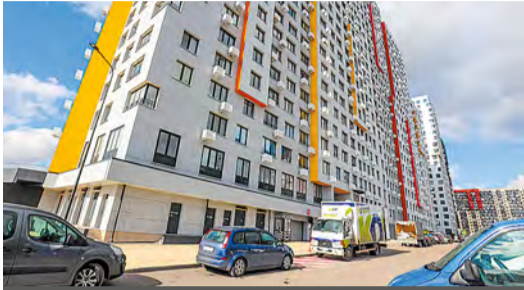
В доме на Родниковой проводились ремонтные работы
