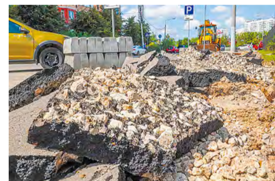
Здесь скоро будут новые дорожки, а справа – зеленый газон
