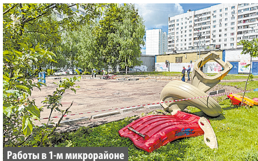
Работы в 1-м микрорайоне
