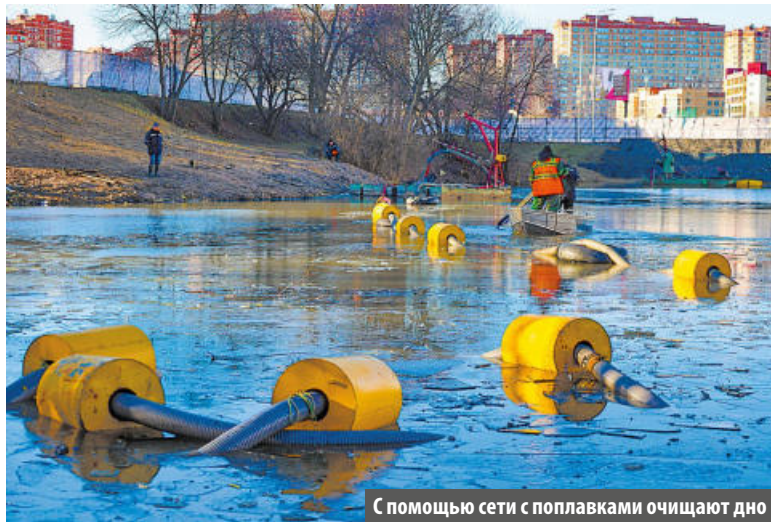
С помощью сети с поплавками очищают дно
